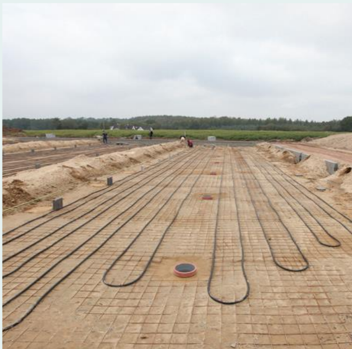
Figur 6: Gyllekøling anlægges under gulvet ved opførsel af ny stald (Klimadan)
